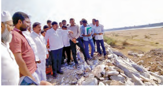
ముక్త్యాల-మాదిపాడు మధ్య కృష్ణానదిపై నిర్మిస్తున్న బ్రిడ్జి పనులను పరిశీలిస్తున్న జగ్గయ్యపేట ఎంఎల్ఏ శ్రీరాం రాజగోపాల్, పెదకూరపాడు ఎంఎల్ఏ భాష్యం ప్రతిక్.
